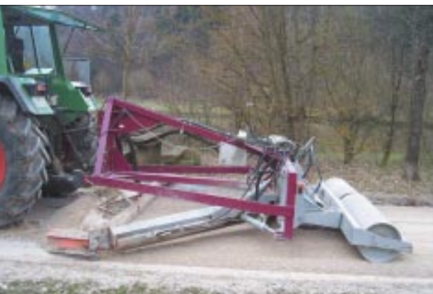
Abb. 3: Profilieren und Vorverdichten einer neuen Decke
