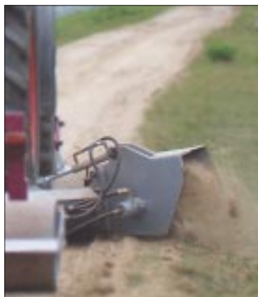
Abb. 4: Die Beseitigung des Materialwulstes am Rand
