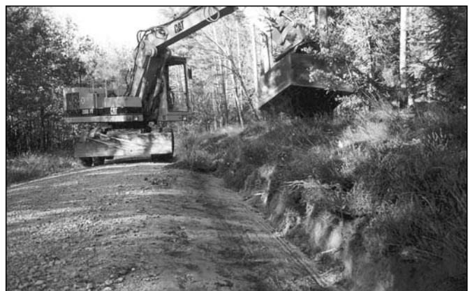
Abb. 1: Der Grabenbagger im Einsatz (Foto: J. SCHMAILZL)
