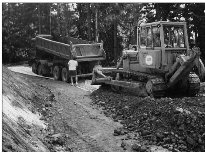
Abb. 2: Planierarbeiten auf dem Höllbichelweg (Fotos (2): S. BAUMEISTER)
