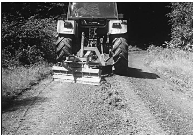
Abb. 3: Hereinholen von Material der Verschleißschicht
