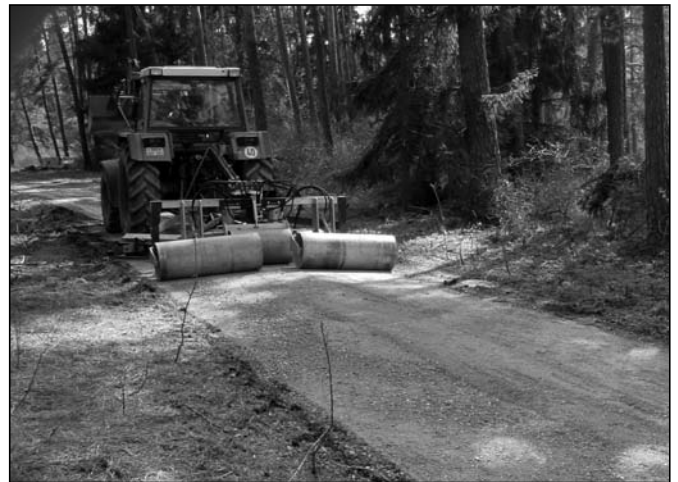
Abb. 1: Anders als beim R 2-Gerät werden beide Wegseiten gleichzeitig gepflegt. (Foto: W. GUGLHÖR)
